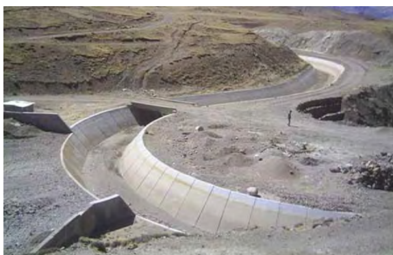
Foto N° 20. Canal a la altura de Ccaracochoa
