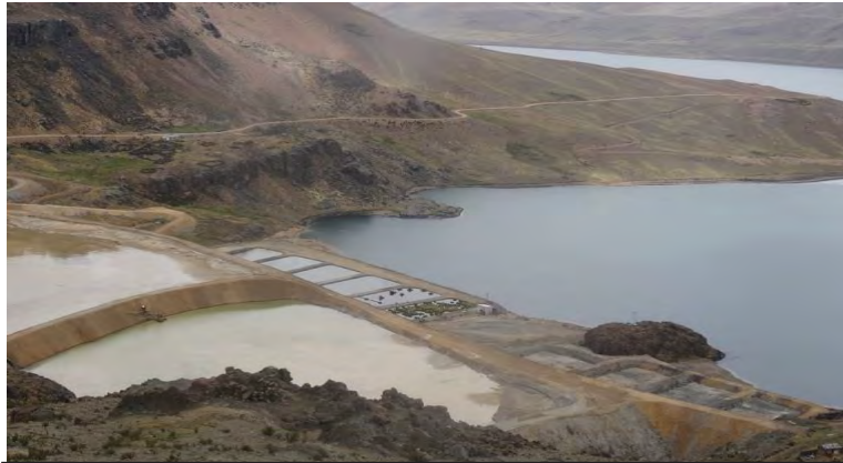
Foto N° 02. Aguas ácidas de mina que se vierten a la laguna Orcococha.
