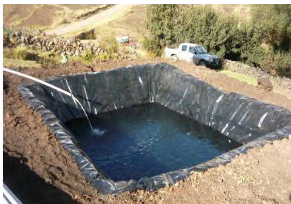
Foto N° 18. Reservorio en Occoro
